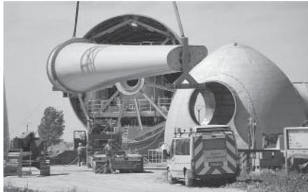
Abb. 1: Vorbereitung der Montage einer WEA (ENERCON E-126; Quelle: ENERCON GMBH, WINDBLATT)
