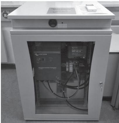
Abb. 3: Leistungselektronik mit Batteriespeicher im Unterrichtsraum
