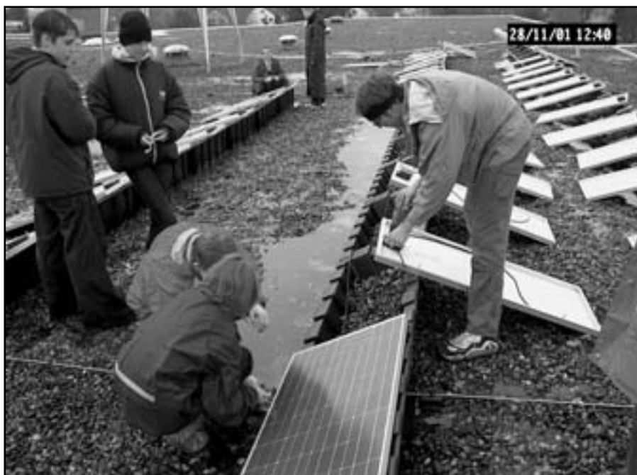
Abb. 1: Schüler beim Bau der Photovoltaikanlage
