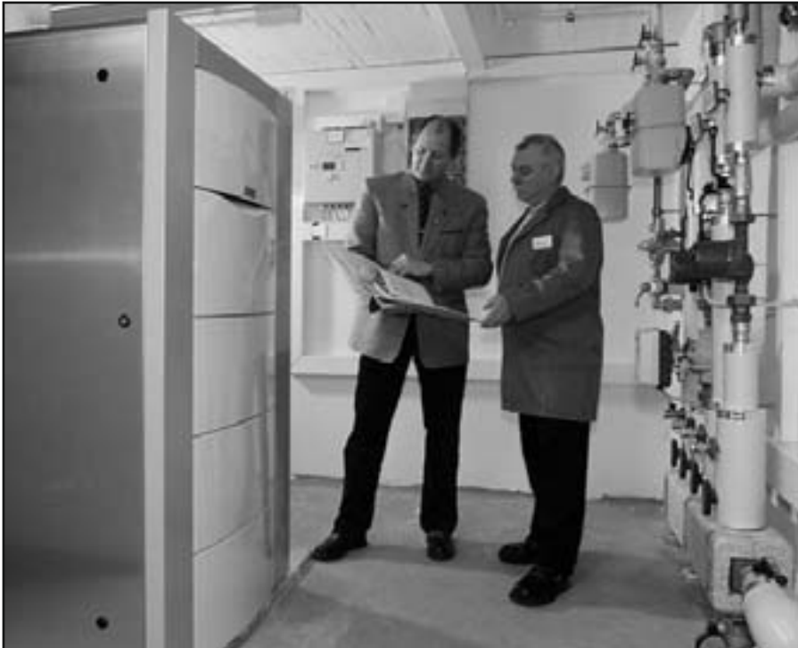
Abb. 3: Stationäre Brennstoffzelle der Vaillant GmbH in einem Wohnhaus (Quelle: VAILLANT GMBH)
