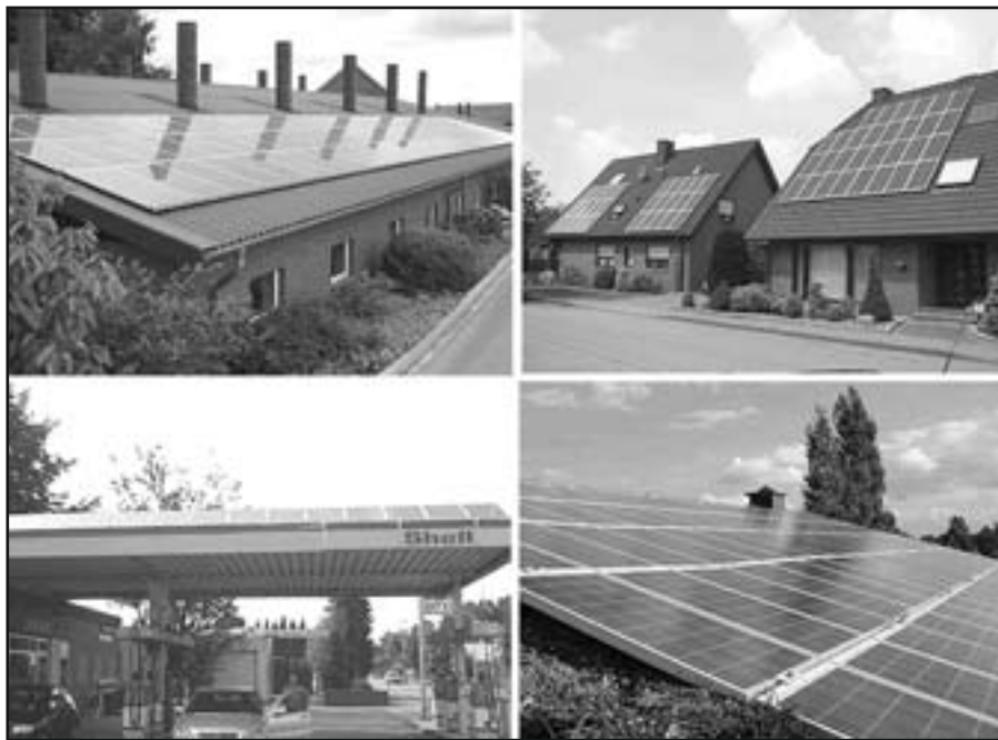
Abb. 3: Werbung von Handwerksbetrieben mit erfolgreich ausgeführten Kundenaufträgen als Referenzobjekten
