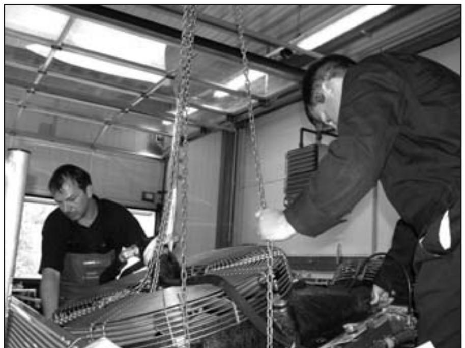
Abb. 4: Demontage einer der Kühlventilatoren auf dem Dach des Brennstoffzellenbusses
