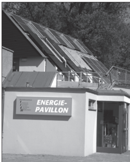
Abb. 3: Energiepavillon des OSZ TIEM
