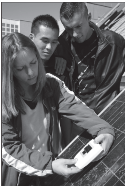
Abb. 4: Lernende führen Messungen an der Photovoltaikanlage durch
